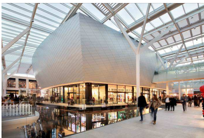
AGENCE D'ARCHITECTURE : ART & BUILD ARCHITECTS CRÉDIT PHOTO : VMZINC® - © GEORGES DE KINDER
