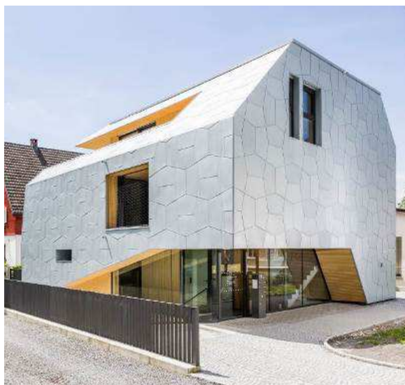
VMZ ECAILLES - AZENGAR ARCHITECTE : HOFFENSCHERARCHITEKTEN CRÉDIT PHOTO : VMZINC / HOFFENSCHERARCHITEKTEN
