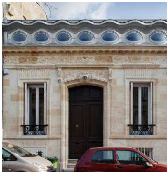
LUCARNES - ZINC NATUREL VMZINC ARCHITECTE : BERTRAND NIVELLE CRÉDIT PHOTO : VMZINC
