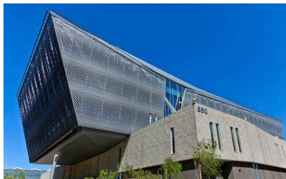
HÔTEL DE POLICE DE PHOENIX, USA VMZ COMPOSITE PERFORÉ - QUARTZ-ZINC® AGENCE D'ARCHITECTURE : GABOR LORANT ARCHITECTS CRÉDIT PHOTO : GILBERTSON PHOTOGRAPHY
