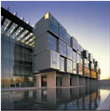
Ecole privée à Waterloo (Canada) Architecte : Trevor Davies Légende Cdrom : EQ PUBL – LAU CAN
