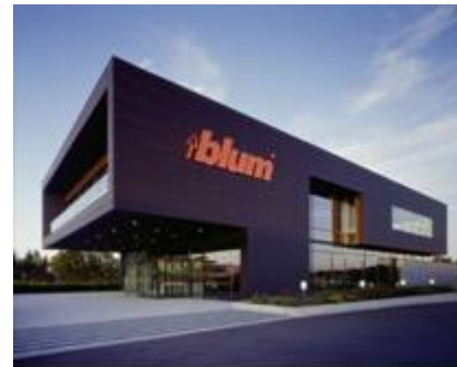
Bureaux et show-room à Herford (Allemagne) Architecte : Dirk Stanczus Légende Cdrom : LI ENTR – ME ALL
