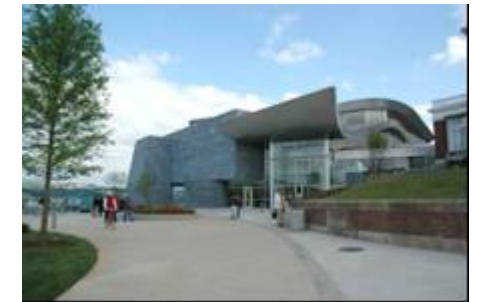
Musée d'Art américain à Chattanooga (USA) Architecte : Randall Stout Architects Légende Cdrom : PX SPEC – PX AUDAC
