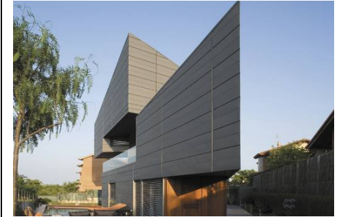
Maison à Barcelone (Espagne) Architecte : Blai Perez Gonzalez Légende Cdrom : PX SPEC - PX AUDAC
