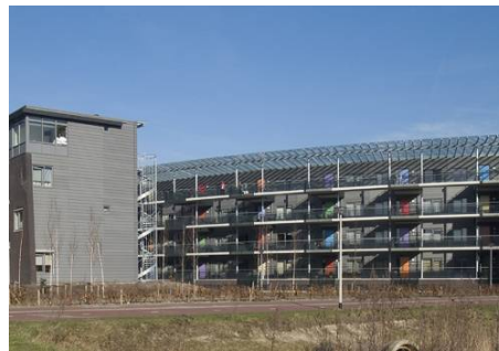
Immeubles de logements sociaux à Roosendaal (Pays-Bas) Architecte : Schaap Tjitse Légende Cdrom : HAB COL - ME PB
