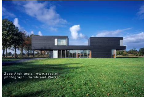
Maison à Vriezenveen (Pays-Bas) Architectes : Marnix Van Der Meer & Rolf Bruggink Légende Cdrom : HAB IND - ME PB
