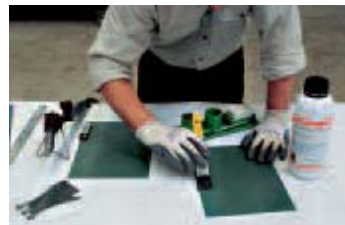
Décapage chimique de la couche pigmentée avec du DECALAQ. Attendre l'apparition de cloques sur l'ensemble des parties traitées.
