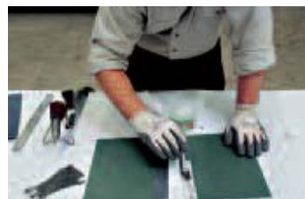
Premier décapage de la couche de prépatinage grise au DECA-VM ZINC.
