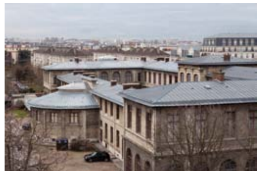
^ Ecole vétérinaire, Maison Alfort (94) Maître d'ouvrage : SECC - Entreprise : Thermosani VMZ Tasseaux - Zinc naturel
