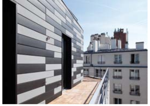
< Logements collectifs privés, Boulogne (92) Entreprise : CIBP VMZ Profil à emboîtement QUARTZ-ZINC® et ANTHRA-ZINC®
