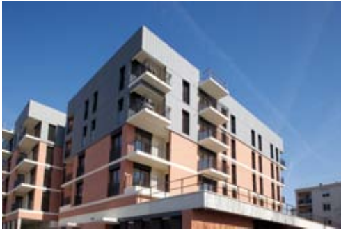
^ Logements sociaux OPHLM, Asnières (92) Architectes : Ateliers 115 - Entreprise : Leroux VMZ Profil à emboîtement - QUARTZ-ZINC®
