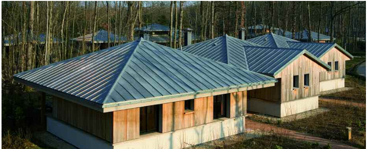
Logements Center Parc, Verneuil (27) Architecte : De Gastines Entreprises : Joly, Bequet, Bonte, Gondouin Joint debout - VM ZINC Naturel
