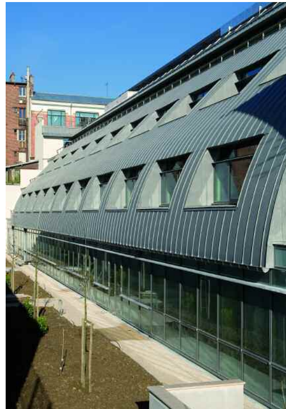
Bureaux SNCF, Clichy (92) Architecte : Architecture et développement Entreprise : Balas Joint debout - QUARTZ-ZINC®
