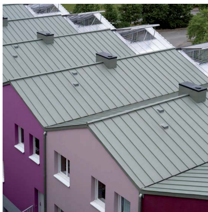
📍 Logement Playtime, Nantes (44) Architecte : TETRAC - Entreprise : Claude Joint debout - PIGMENTO® vert lichen
