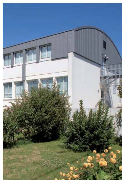
📍 École "poule-piquant", Muzillac (56) Architecte : AGORA, M. Le Huidoux - Entreprise : Boussicaud Michel - Joint debout - QUARTZ-ZINC®
