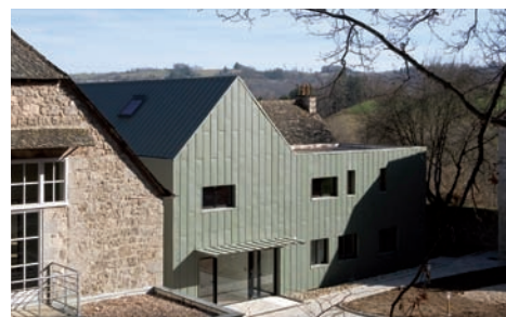
Domaine de la Borie, Senergues - Architecte : Couderc Architecte - Entreprise : Delbes
