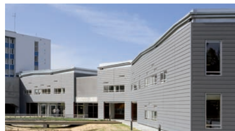
Bureaux EADS, Méridac - Architecte : Bienfait - Entreprise : Soblaco
