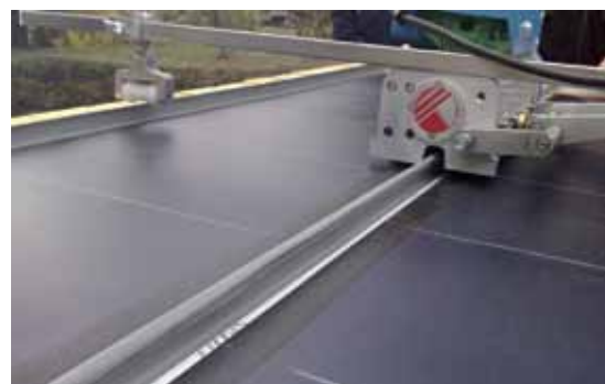
Fig. 14 : Sertisseuse spéciale solaire DIMOS ref. DIPRO SRTS
