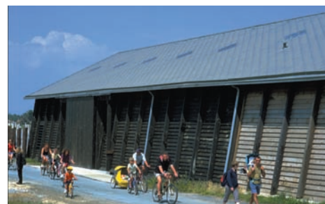
Hangar à sel, Ile de Ré (17) - Architecte : Bonin - Entreprise : Muertes
